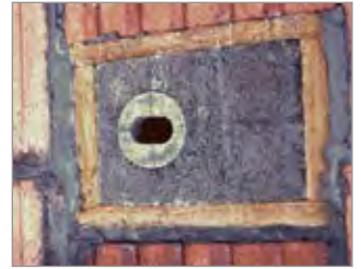
▲ zur Verhinderung von Kältebrücken (Isolierung bauseits)
