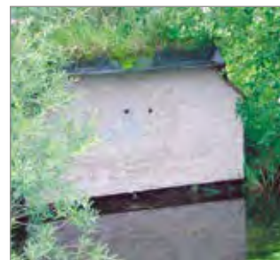
▲ künstlich angelegte Uferböschung
