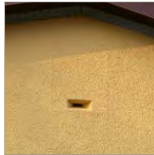
▲ Montagebeispiel unter Putz unter dem Dachfirst
