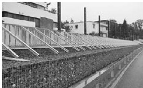
Auf dieser Unterkonstruktion an der Lärmschutzwand entstand die Photovoltaikanlage.
