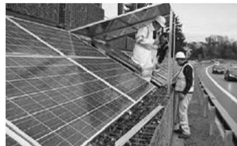
Unter klappbaren Elementen sind die technischen Geräte versteckt.
